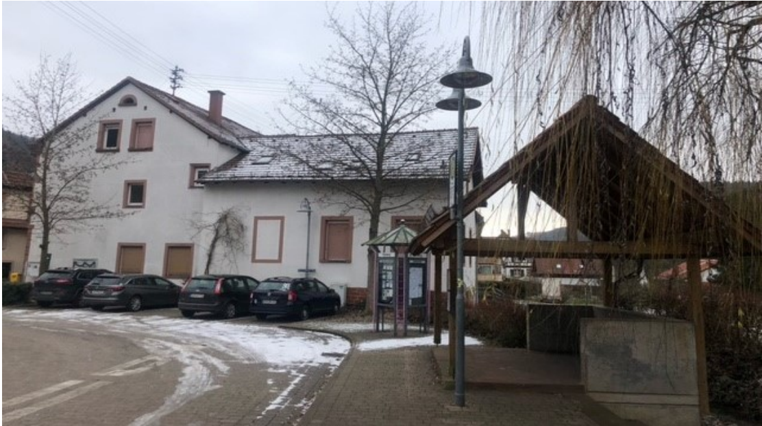
Bild 8: Blick vom nördlichen Parkplatz auf die Nordfassade, Flurstück 178
